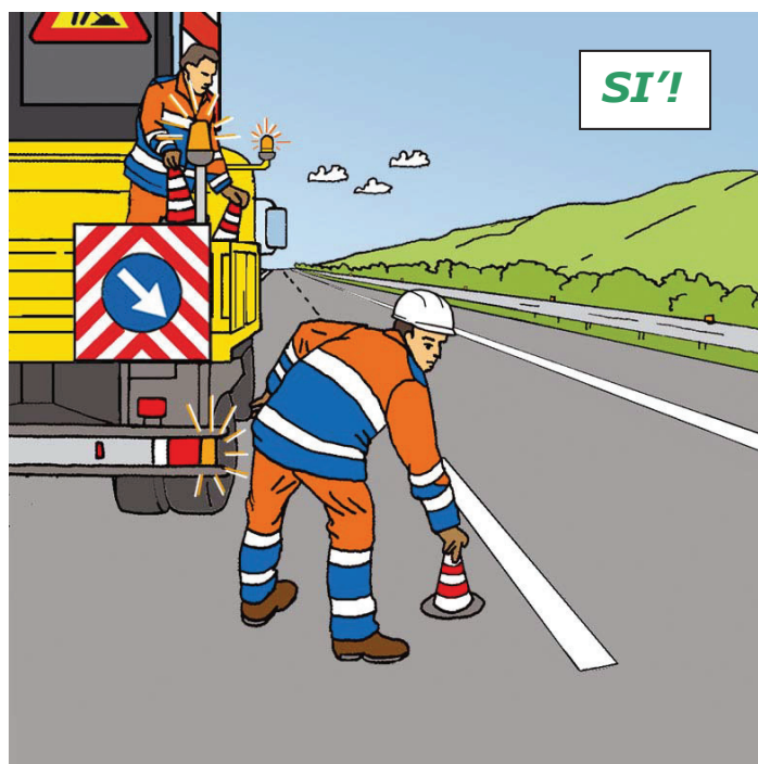
Figura 59 – Posizionamento dei coni o defleco: comportamento corretto
